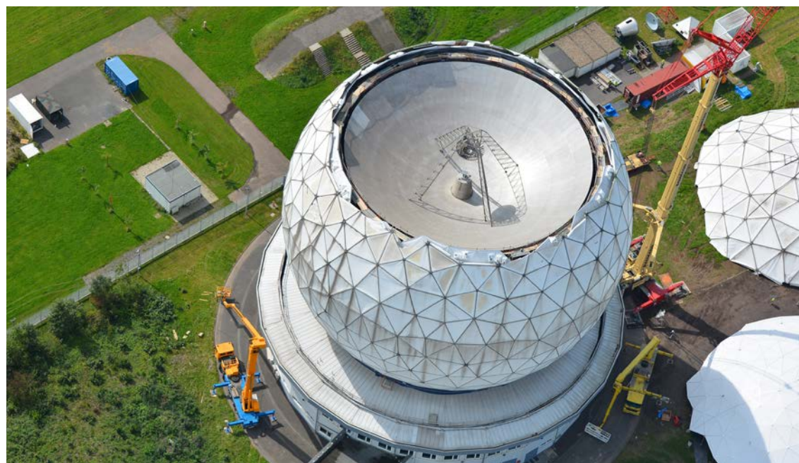
Seltener Anblick: Ein Blick ins offene Radom während der Erneuerung 2014
